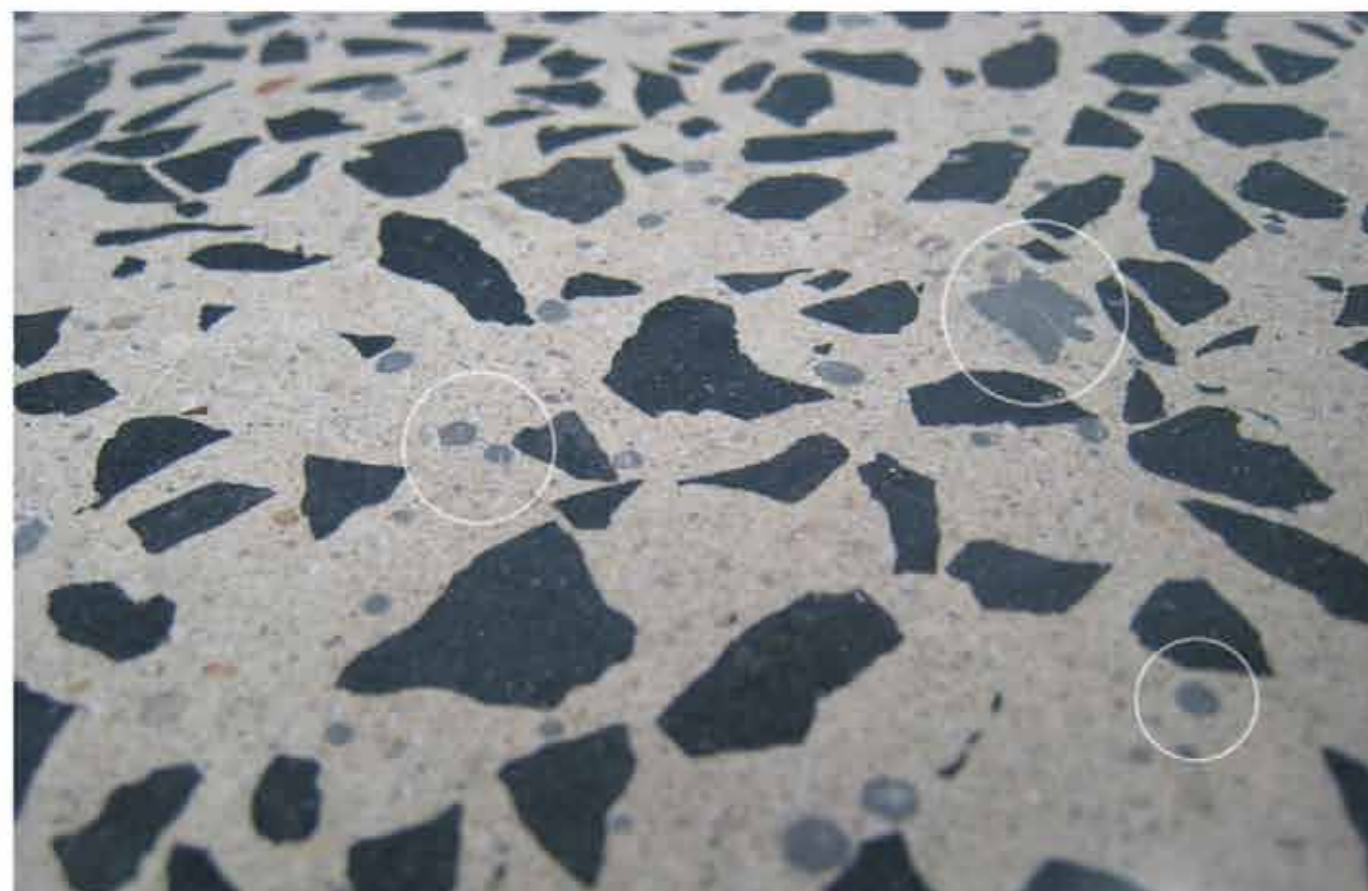
Заполнение отверстий при шлифовке инструментом с зерном 120 с металлической связкой и GM 3000™.
