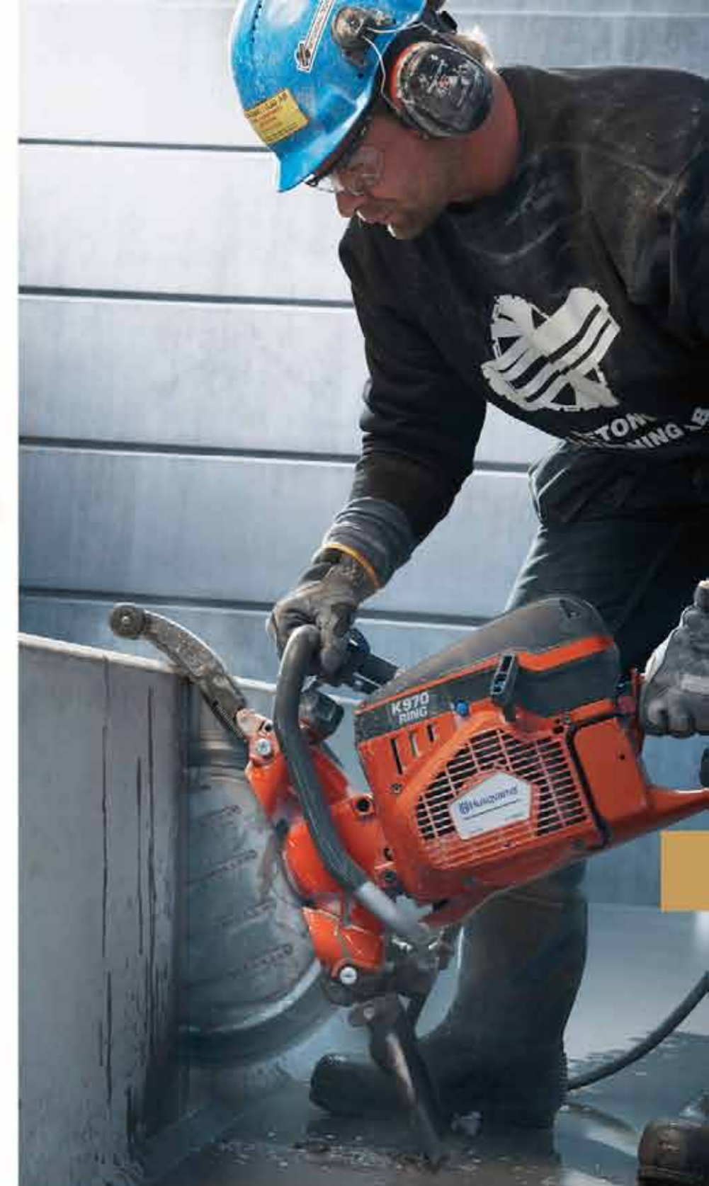
Глубина резки 270 мм, вдвое больше, чем у обычных дисковых резчиков.
